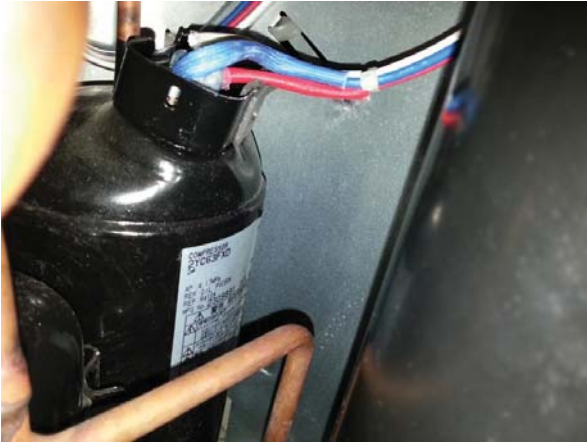
การวัดโดยใช้เมกะโอมห์วัดค่าความเป็นฉนวนของขดลวดคอมเพรสเซอร์
