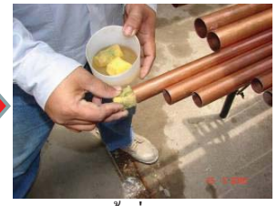
4 ยัดฟองน้ำที่ผสมอะซิโตนเข้าไปในท่อทองแดง
